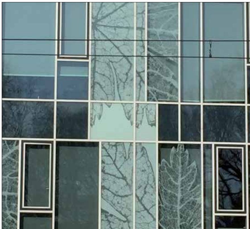
Fot. 6. Biurowiec Botanica Residence, Wrocław
