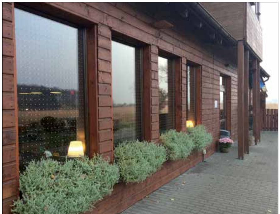
Fot. 1. Restauracja Przyszań Ptasi Raj, Wyspa Sobieszewska (fot. L. Pilacka)
